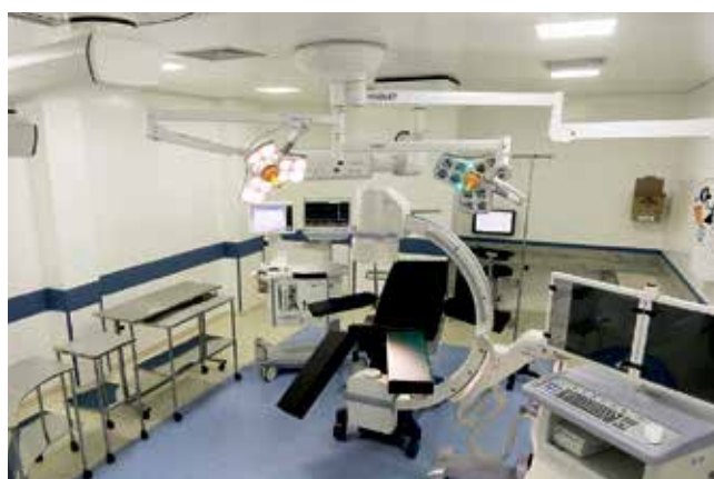
Centro cirúrgico do Hospital Memorial da Uningá, que possui área total de cerca de 3.500 metros quadrados, profissionais capacitados e equipamentos modernos
